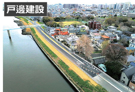
R 5 中川右岸中川五丁目地先堤防整備工事
