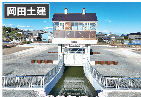
R 5 利根川左岸荒波樋管新設工事
