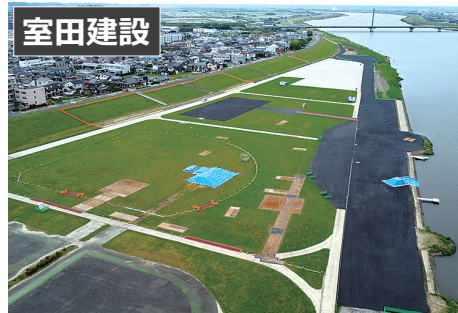
R 5・6 利根川右岸佐原地先高水敷整備工事
